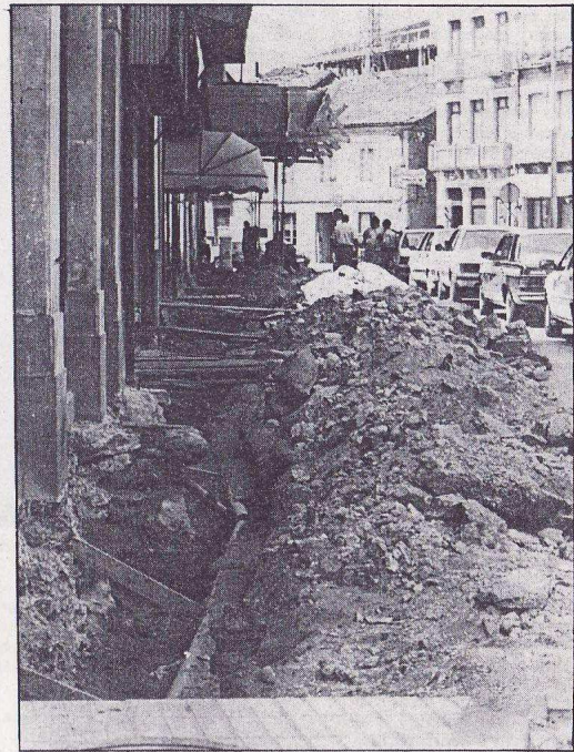
La plaza está estos días en obras
